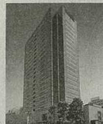
⑮ 武蔵小杉駅前事務所
