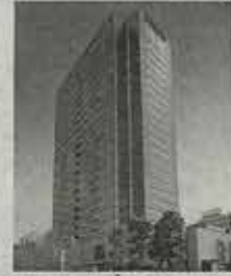
⑨武蔵小杉駅前事務所
