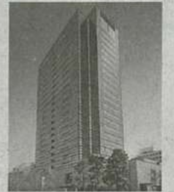
⑨武蔵小杉駅前事務所
