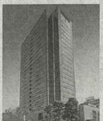
⑨武蔵小杉駅前事務所
