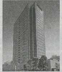
⑨ 武蔵小杉駅前事務所
